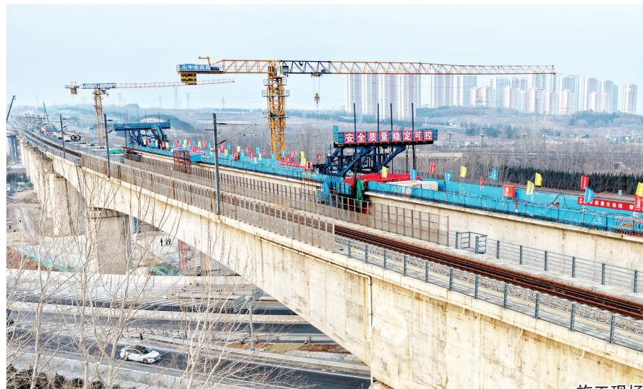
位筑牢冬施安全质量防线,确保合龙段浇筑施工稳步推进、一次成型。
