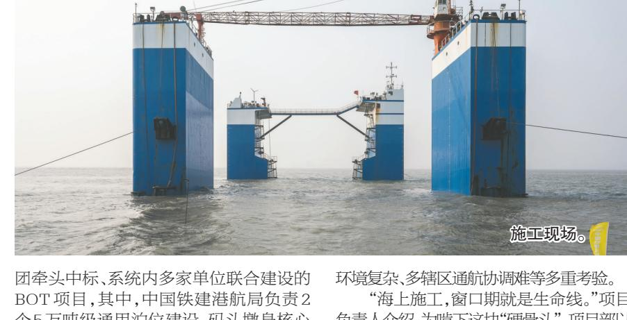
特点，项目大部分沉箱出运安装均在夜间完成，最低气温接近零下，海上寒风裹挟着海浪，给施工带来极大考验。“我们实行轮班值守，24小时紧盯潮汐、风浪、气温等实时数据，抓住每一个有效作业窗口期赶潮施工。”现场施工负责人说，项目领导班子全程驻守一线指挥调度，技术、安全、测量、施工人员各司其职、协同作战，顶寒风、战低温，在夜间作业中精准把控每一个操作细节，确保沉箱安装精度误差控制在规范范围内，实现“零失误、零事故”。
