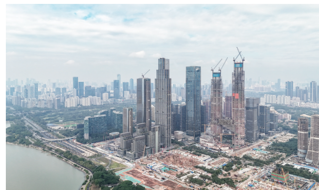
这是建设中的深圳湾超级总部基地(12月19日摄,无人机照片)。12月19日,由深湾发展投资建设、中建五局承建的深圳湾超级总部基地C塔项目主体结构封顶。C塔项目位于深圳湾超级总部基地“十字双轴”空间格局的中心区位,总建筑面积54.8万平方米,由东塔与西塔两座塔楼组成,将被打造成为集办公、酒店、商业、文化、交通于一体的多业态综合体。 新华社
