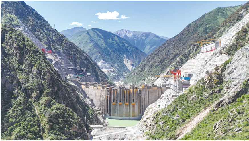
这是2025年6月30日拍摄的建设中的叶巴滩水电站(无人机照片)。该水电站地处四川甘孜州白玉县与西藏昌都市贡觉县交界处的金沙江上游，总装机容量224万千瓦。
