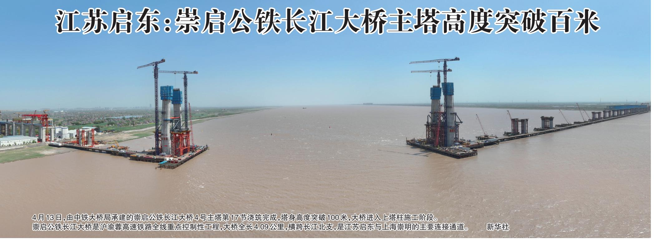
4月13日,由中铁大桥局承建的崇启公铁长江大桥4号主塔第17节浇筑完成,塔身高度突破100米,大桥进入上塔柱施工阶段。
