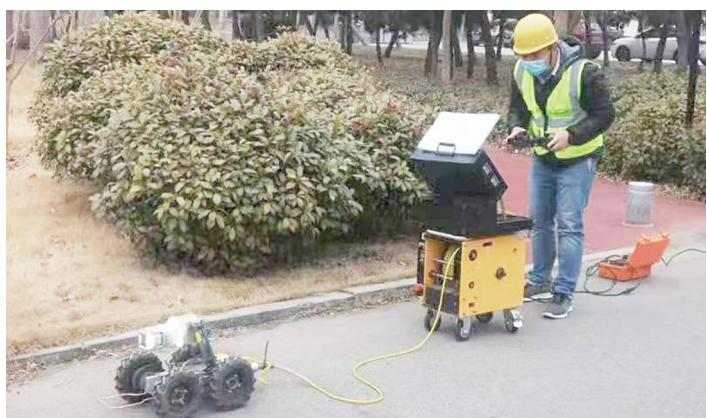
本报讯(YMG全媒体记者 杨春娜 通讯员 李静 摄影报道)昨天,记者在莱山区逛荡河东路看到,市城管局城市排水服务中心的工作人员正对雨污水管进行清淤。今年清淤作业中,机器人发挥了重要的作用,为管道做起了“肠镜”检查,确保清淤工作精准高效。
