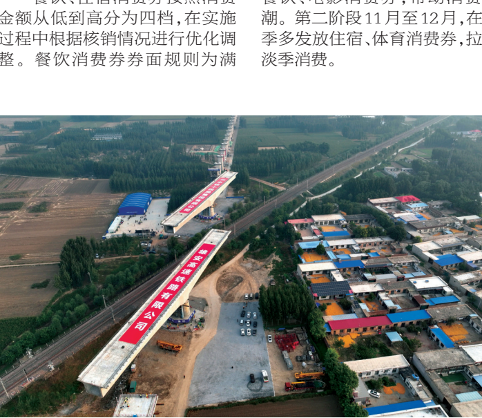
9月25日,雄商高铁任丘特大桥跨京九铁路成功转体。该桥是雄商高铁全线跨度最大的转体桥,同时也是全线七座转体桥中第一座完成转体施工的桥梁。新华社
