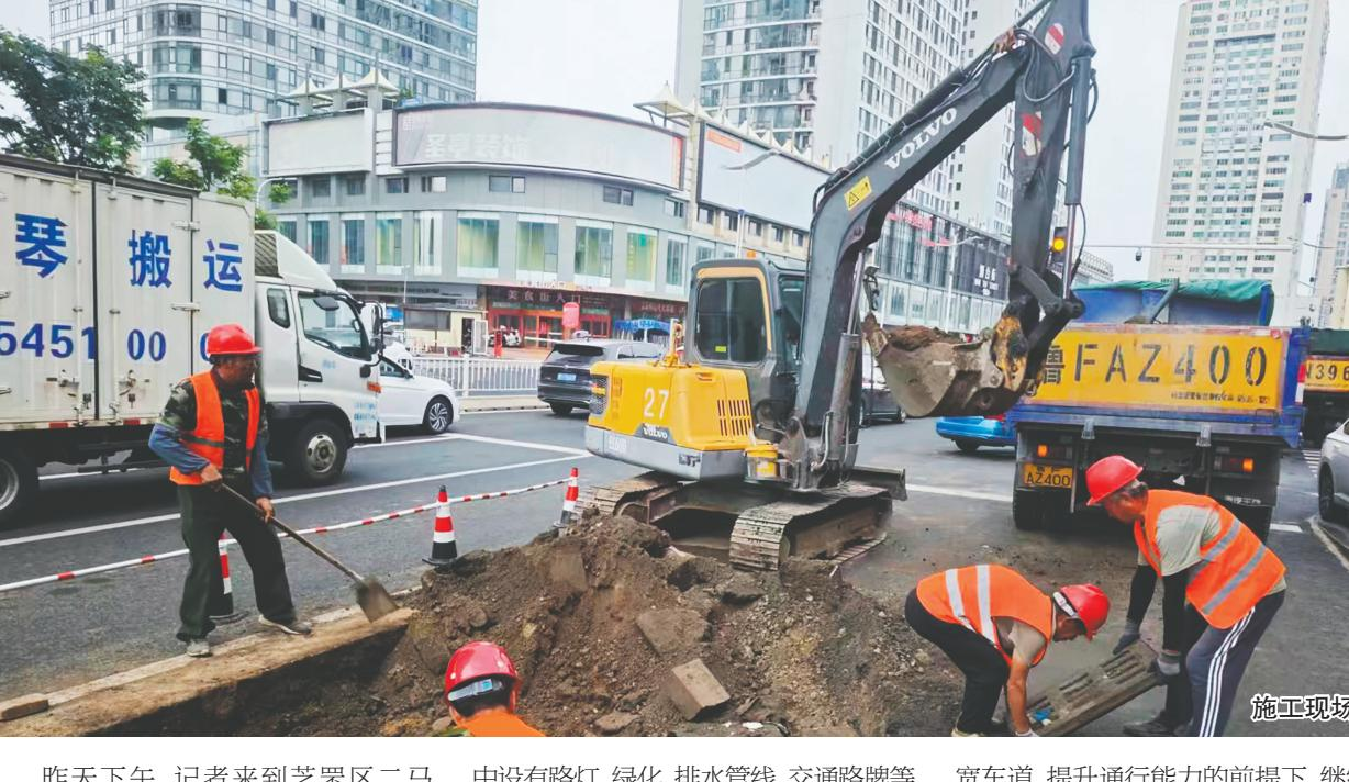
昨天下午，记者来到芝罘区二马路，原有的车行道绿化分隔带已经启动拆除。市城管局市政养护中心工作人员介绍，此次将拆除约400米分隔带，一并进行道路拓宽和路面恢复，整体改造项目预计将在8月下旬完成，让二马路更加畅通。
