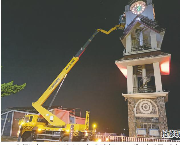
本报讯(YMG全媒体记者 杨春娜 通讯员 孙鹏展 李畅 摄影报道)昨天凌晨1点左右，降雨还未来临。市政中心抢修小组赶在下一场降雨前开展灯组抢修作业，工作人员配合高空作业车很快完成修复工作，重新安装脱落洗墙灯2套、固定松动灯具4套、固定灯组桥架10余米，确保瞭望塔处灯组安全隐患及时消除。
