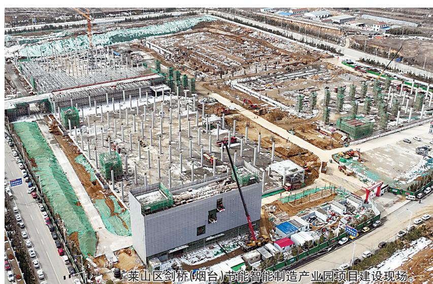
到,建筑工人和机械设备正在按照项目既定进度加紧施工。建设方在去年完成1—3号主体施工的基础上,于年初启动了1号和2号厂房基础回填、钢结构搭建工作,目前这两项工程已进入尾声,3号厂房主体正准备进行外墙
