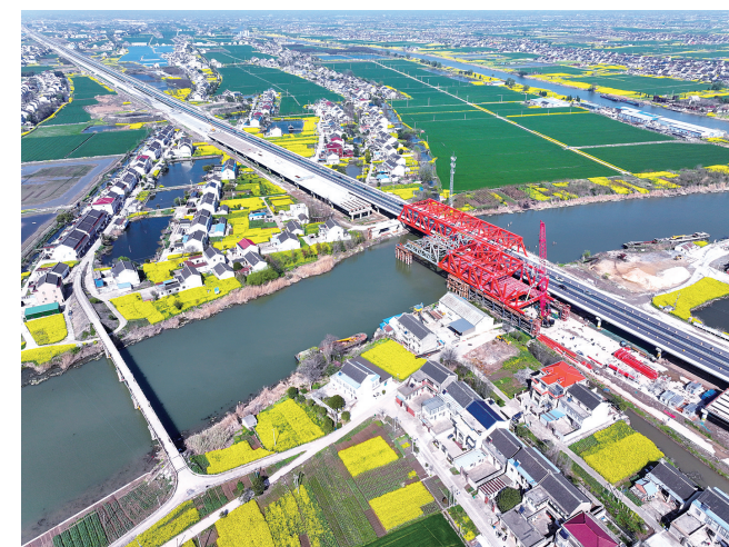
这是3月29日拍摄的沪陕高速公路平湖至广陵段扩建工程施工现场(无人机照片)。 沪陕高速公路平湖至广陵段扩建工程起自江苏南通平湖北枢纽，止于泰州广陵枢纽东，全长约48.966公里，计划2024年年底建成。目前，南通段路面基层已全部完成，正在有序推进沥青面层施工；泰州段正在稳步开展桥梁工程、主桥钢梁拼装等作业。 新华社
