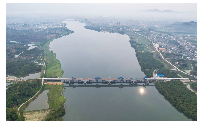
3月29日，揭惠铁路榕江南河特大桥主跨连续梁合龙(无人机照片)。 当日，由中铁四局承建的揭(阳)惠(来)铁路榕江南河特大桥主跨连续梁合龙，该桥全长1576.84米，是全线最长的跨水域桥梁。 揭惠铁路位于广东省揭阳市内，起自梅汕铁路揭阳站，终至汕汕铁路惠来站，新建正线全长88.66公里，设计时速160公里。建成通车后进一步完善粤东地区城际铁路网，密切与粤港澳大湾区以及东南沿海地区的联系。 新华社
