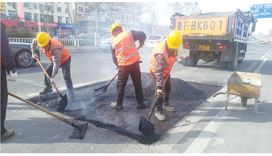
施工人员正在对一处道路网裂进行处理。
