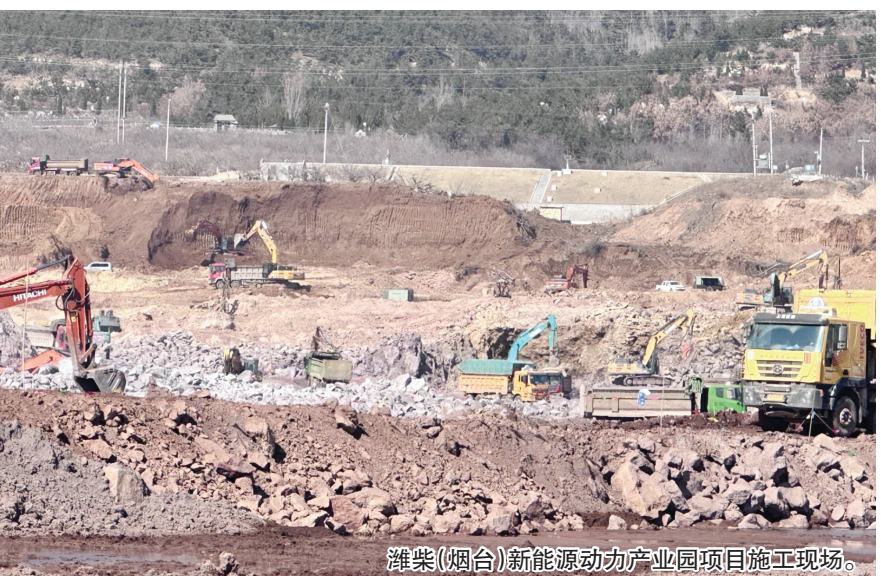
潍柴(烟台)新能源动力电池产业园项目施工现场。
