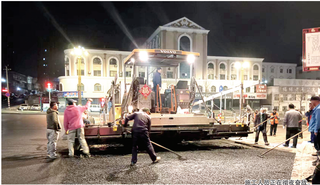
施工人员在彻夜奋战。
