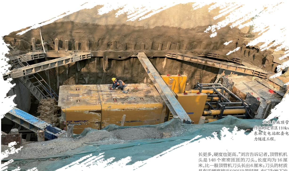
正在实施顶管作业的芝罘区110kv东林变电站配套电力隧道工程。
