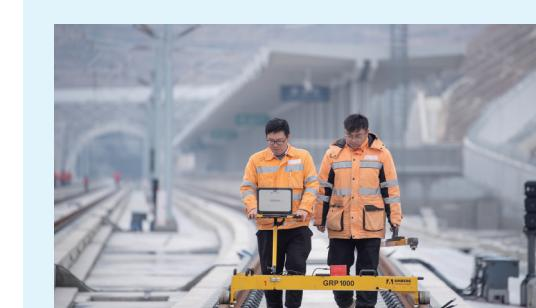
2月27日,铁路宁波工务段职工使用轨道检查仪对杭温铁路轨道进行几何误差的测量作业。杭温铁路(杭州至温州高速铁路)是一条串联浙江省内杭州、金华、温州三大都市圈,对打造浙江省“一小时交通圈”具有重要意义的高速铁路。目前,杭温铁路全线铺轨已经接近完工,来自铁路宁波工务段的30余名铁路“精调师”也随着铺轨工程同步开展测量、精调轨道几何误差的工作,确保杭温铁路安全顺利开通运营。
