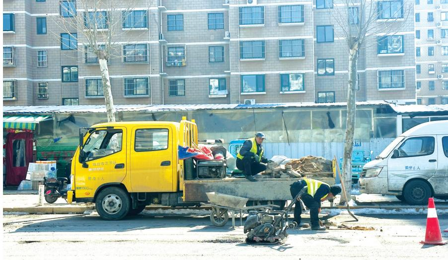
路面填平。记者就此事采访了芝罘区综合行政执法局市政设施科,一名工作人员告诉记者:“路面破损是由融雪剂和铲雪车导致的,我们从下雪后就一直对负责的路面进行维修。由于天气寒冷,我们只能先用砂砾、水泥等先把路面暂时填平,但是这些材料不扛车压。”这名工作人员表示,预计3月底天气转暖,他们将会给这些破损的路面铺设沥青。
