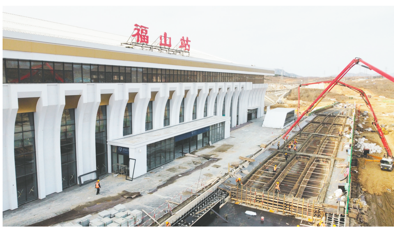
福山区高铁站。
