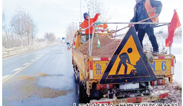
人工机械配合,抛撒环保防滑材料。
