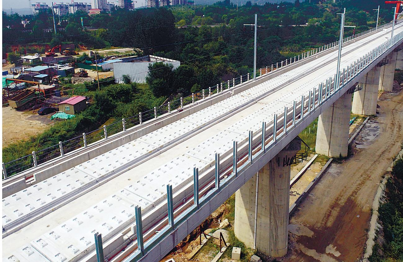
昨日，潍烟高铁福山段最后一段无砟道床板浇筑完成，标志着项目全线无砟轨道工程完工。
