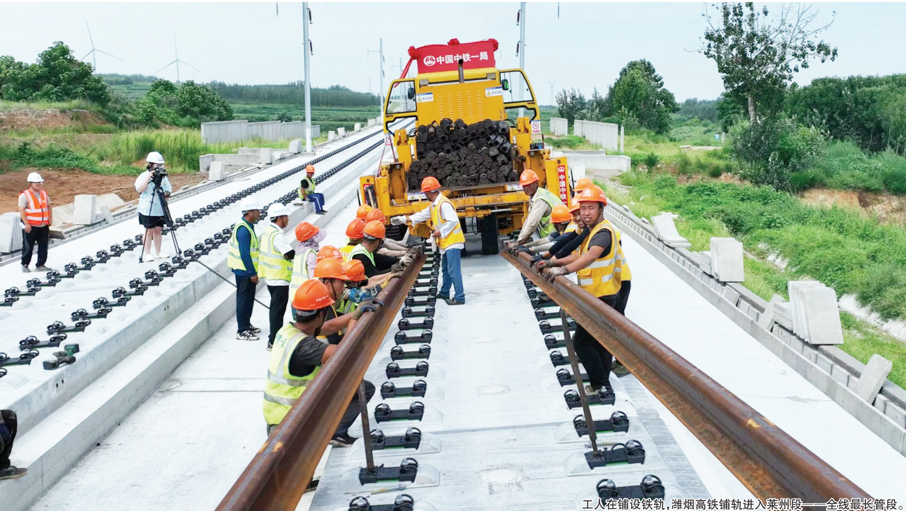
工人在铺设铁轨，潍烟高铁铺轨进入莱州段——全线最长管段。
