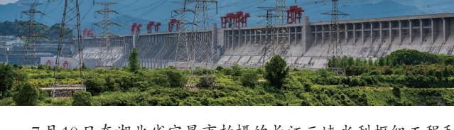
7月10日在湖北省宜昌市拍摄的长江三峡水利枢纽工程和左岸外送输电线路。2023年7月10日，三峡电站首台机组投产发电20年。20年来，三峡电站已累计发出16000多亿千瓦时清洁电能。三峡电站共安装34台水轮发电机组，总装机容量2250万千瓦，年设计发电量882亿千瓦时，是我国“西电东送”和“南北互供”的骨干电源点，电能昼夜不息地送往华东、华中、广东等地。
