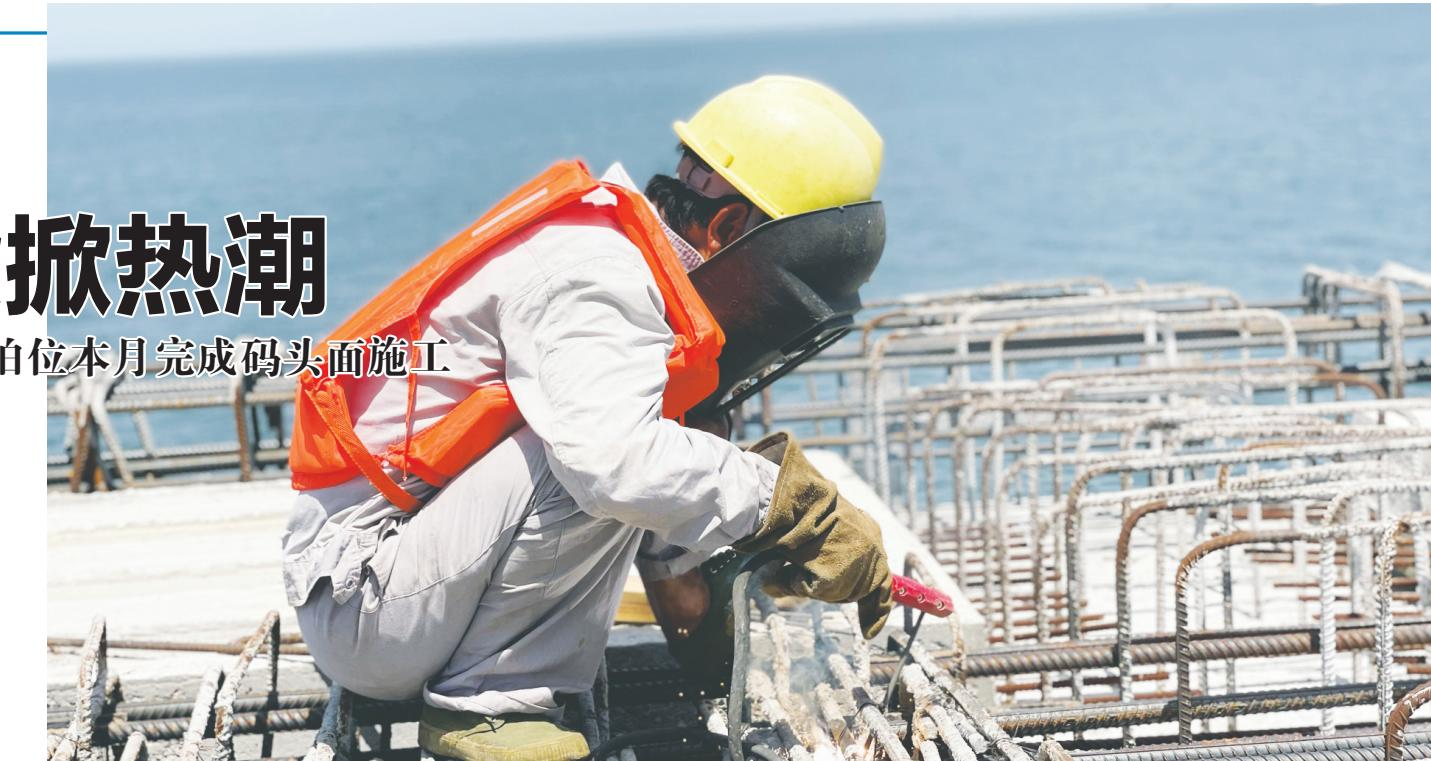
目前在建的烟台港龙口港区南作业区通用、液散泊位工程,共5个泊位,包含1个10万吨级通用泊位、3个5万吨级液化泊位和1个10万吨级油品泊位,均为高桩梁板式结构。
