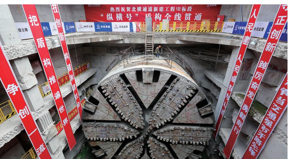
6月6日拍摄的北横通道新建工程Ⅷ标段安国路井内的“纵横号”盾构刀盘。
