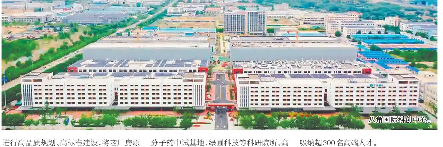
进行高品质规划、高标准建设，将老厂房原有大通间的结构打开，塑造开放、共享的公共区域中庭，同时优化厂房面积分割，满足新型高科技企业对于层高、隔断等需求。经过精心打造后，项目总建筑面积达13.6万平方米，容积率由原0.8提升至1.77，土地利用率提升100%，载体总量达到原体量的200%。
