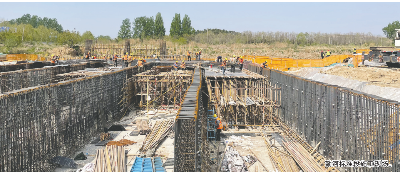
勤河标准段施工现场。
