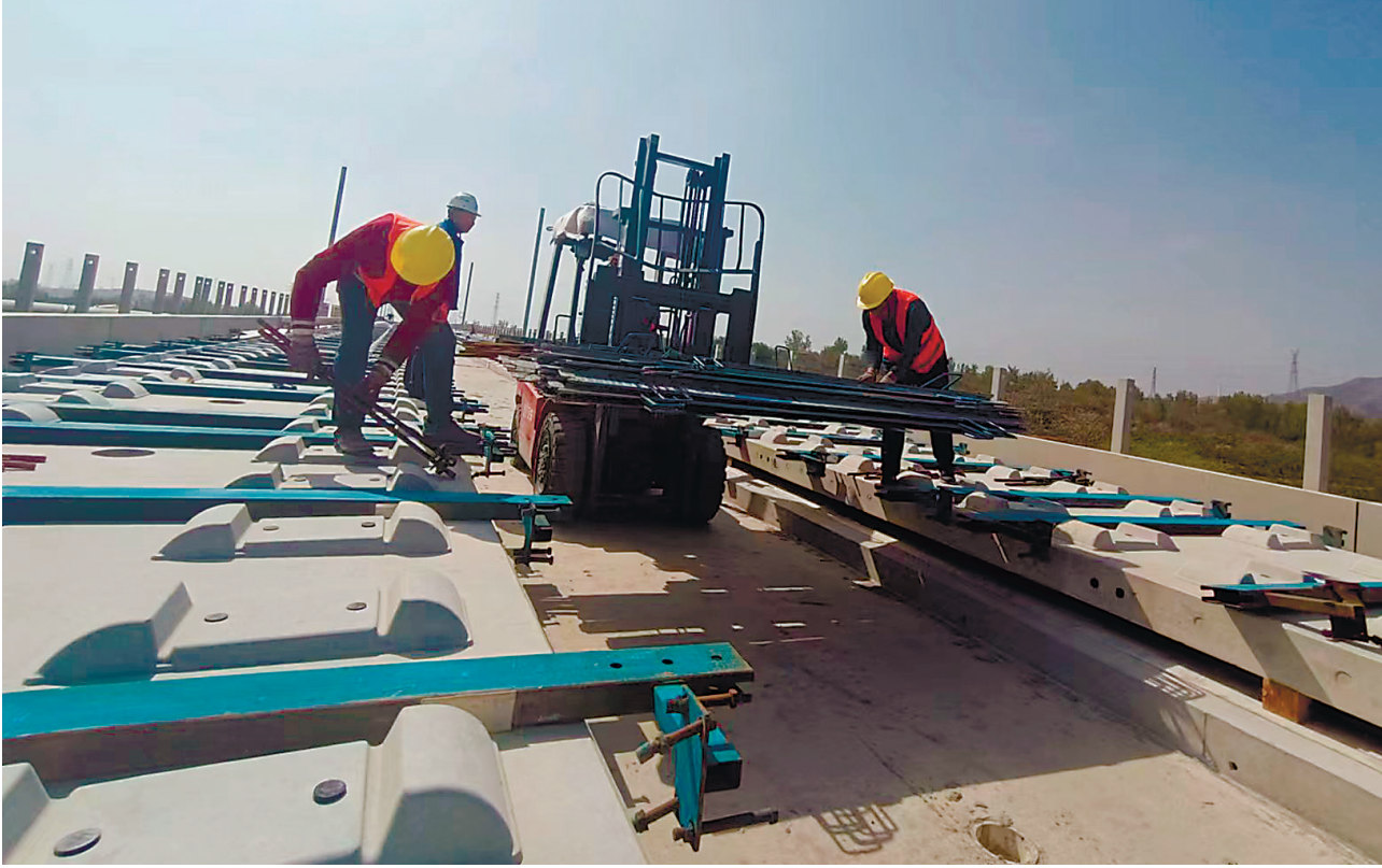
在潍烟高铁福山跨沈海高速特大桥上，施工人员进行无砟轨道铺板作业。
