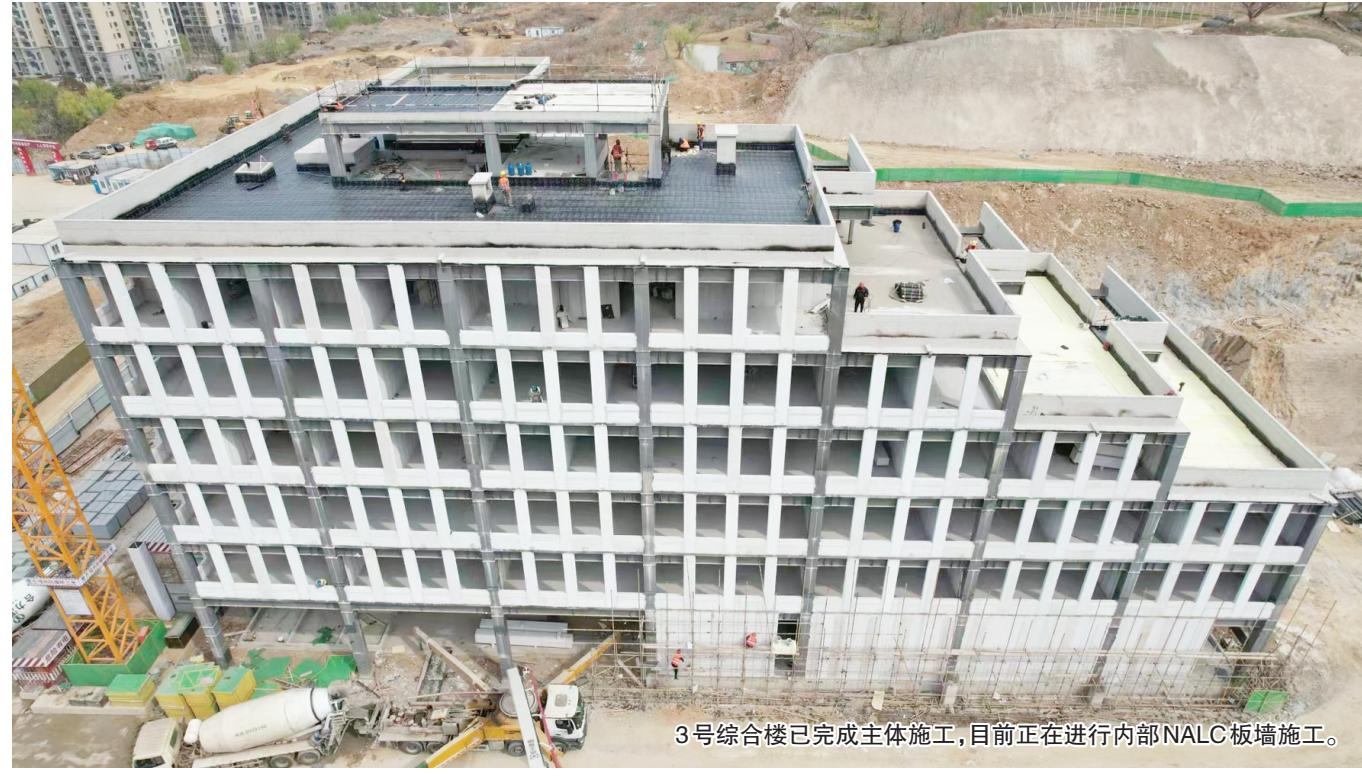
3号综合楼已完成主体施工，目前正在内部NALC板墙施工。
