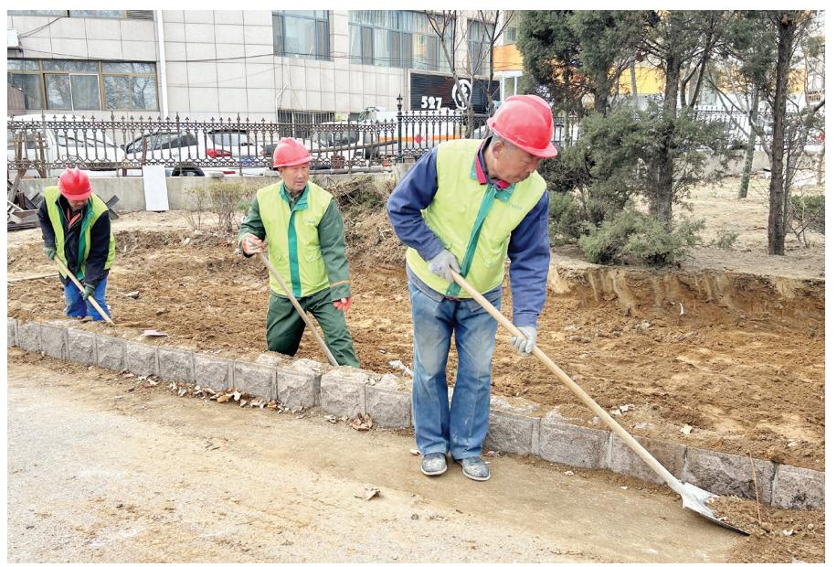
“解放路道路两侧的改造提升,围绕9个节点展开,其中有3个突出亮点。”张辉介绍,三角绿岛位于解放路和大马路交汇夹角处,大马路与解放路均为城市主干道,车流量密集,而且北侧为张裕酿酒公司、金贡山旧宅,东侧为世茂海湾大厦,是展示城市形象的重要节点,但是三角绿岛的现状不尽如人意,岛内植物单一,地面铺装破损,缺乏城市形象展示空间,而且北侧人行空间受阻,交通流线不畅。本次改造将保留原有的法桐行道树,去除杂乱的地被植物,栽植造型松,搭建穿孔板矮墙,重新铺装地面,打造“盆景绿岛”景观,另外,在交通上梳理人行流线,打开场地视通廊道。
