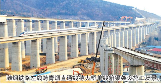
潍烟铁路左线跨青烟直通线特大桥单线箱梁架设施工场景。
