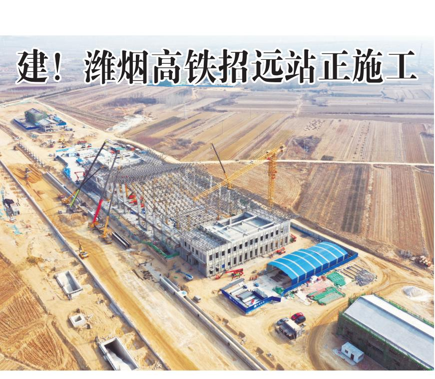
2月21日，来自全国各地的100多名中建八局的工程施工人员正在潍烟高铁招远站项目建设现场进行站场钢网架工程安装及幕墙龙骨施工。
