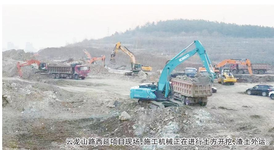
云龙山路西延项目现场，施工机械正在进行土方开挖、渣土外运。
