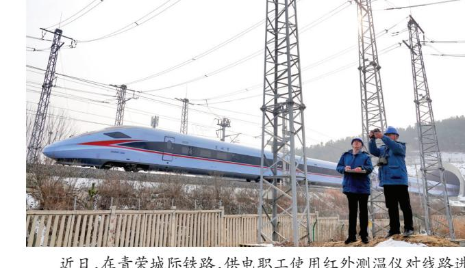
近日,在青荣城际铁路,供电职工使用红外测温仪对线路进行检测,确保春运期间铁路交通用电安全稳定。
