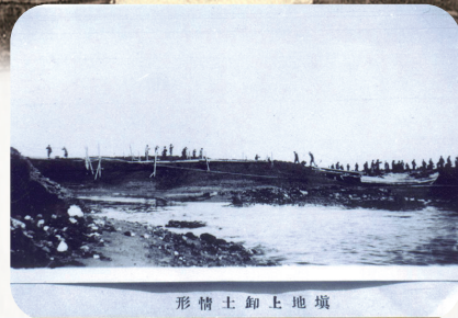
1915年,烟台港西防波堤建设中。
