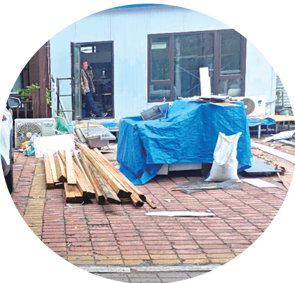
21号商铺正在施工
