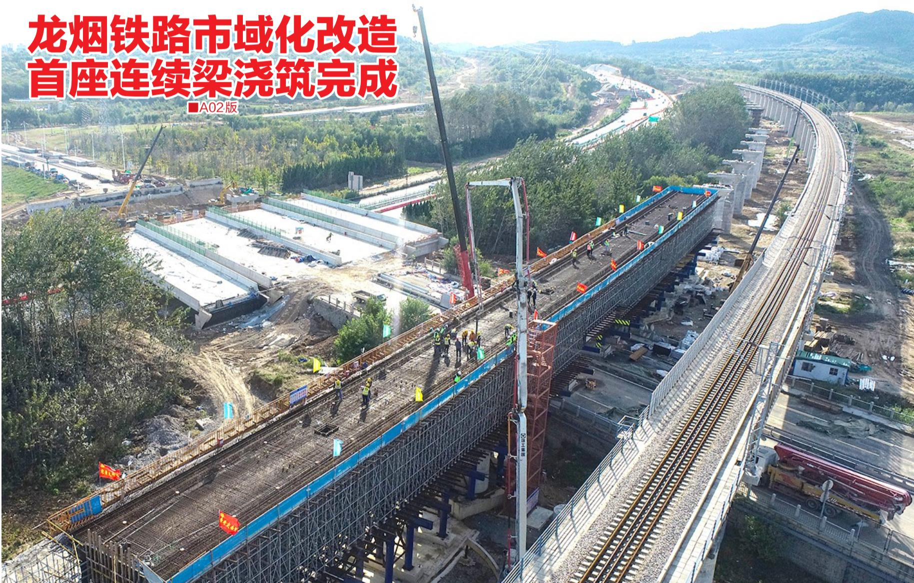
10月22日晚,龙烟铁路市域化改造工程首座连续梁——臧家特大桥64米连续梁顺利浇筑完成。 YMG全媒体记者 杨春娜 通讯员 刘陈永 蒲枭 摄
