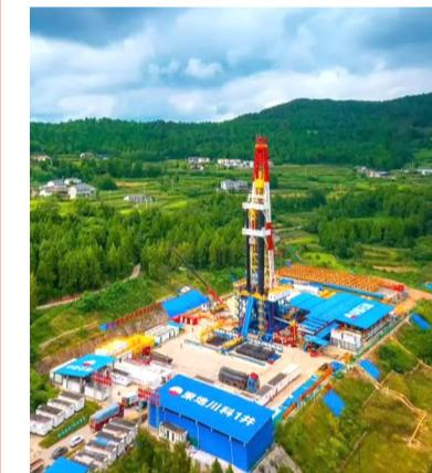
15日9时16分，位于四川省剑阁县的中国石油深地川科1井钻探深度突破10000米。这一地质条件极其复杂、钻井难度极高的深地“超级工程”已钻穿23套地层，深入5.4亿年前的震旦系地层，首次进入四川盆地深部“无人区”，标志着我国在地球深部能源探索领域迈出关键一步。
