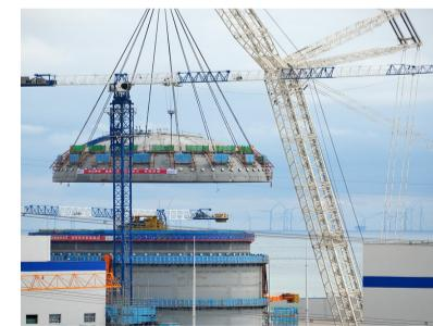
本报讯(YMG全媒体记者 唐克 摄影报道)6日,国家电投山东海阳核电站4号机组核岛钢制安全壳顶封头模块顺利吊装就位,反应堆厂房实现封顶。据了解,建设中的海阳核电3、4号机组是国家“十四五”规划重点项目,全部采用自主设计、国产化CAP1000技术,计划2027年全面投运。
