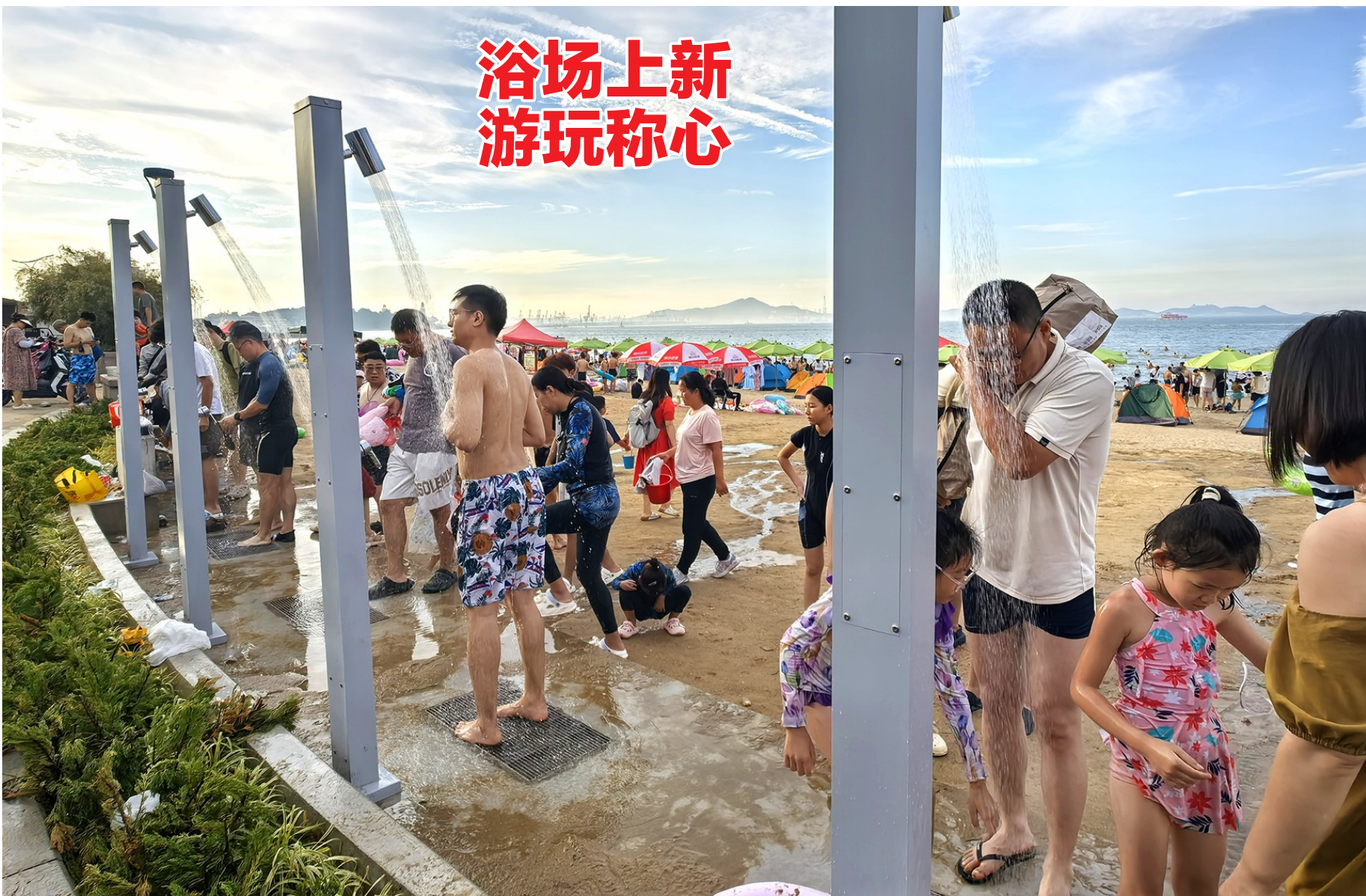
近日,烟台市第一海水浴场新增的6套淋浴设施、6套冲脚设施、2套直饮水设施全部投入使用,在建的淋浴间和公共卫生间将于月底完工。 YMG全媒体记者 柴向阳 摄
