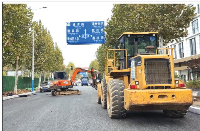
协调,产权单位将进行迁移。迁移完成后,这个路段将进行水稳摊铺,随着主路一起进行沥青面层的摊铺。
