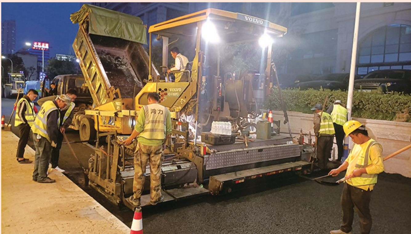
10月28日傍晚,为方便市民出行,在芝罘区玉祥街,工人师傅们加班加点摊铺沥青。YMG全媒体记者 金海善 摄
