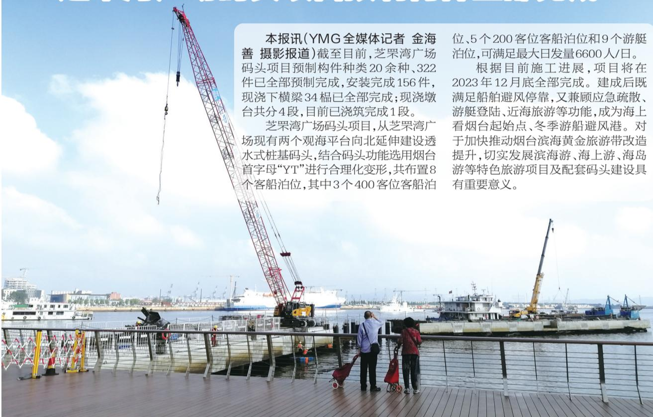
本报讯(YMG全媒体记者 金海善 摄影报道)截至目前，芝罘湾广场码头项目预制构件种类20余种、322件已全部预制完成，安装完成156件，现浇下横梁34樁已全部完成；现浇墩台共分4段，目前已浇筑完成1段。
