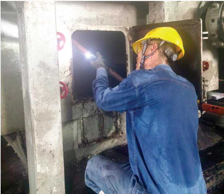
工作人员清理落煤筒杂物。
