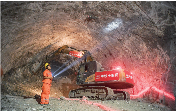
7月24日，工人在渝厦高铁重庆菜园坝长江铁路隧道贯通面进行巡检作业。
