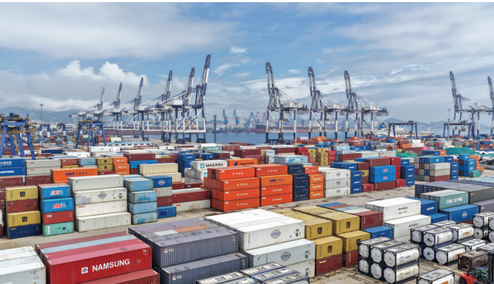
7月14日拍摄的山东港口烟台港国际集装箱码头(无人机照片)。 海关总署7月14日发布数据显示,2026年上半年我国货物贸易进出口总值25.47万亿元,历史同期首破25万亿元,同比实现16.9%的增长,稳居全球货物贸易第一大国地位。 新华社
