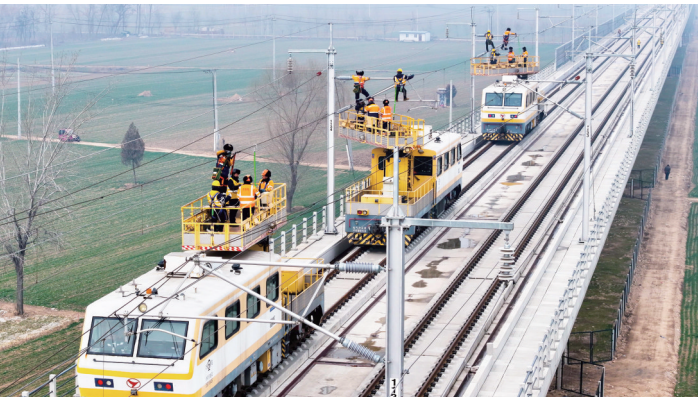
2月1日,在雄商高铁山东菏泽段,中国铁路济南局集团有限公司济南供电段的工作人员对接触网设备进行检查验收(无人机照片)。新华社
