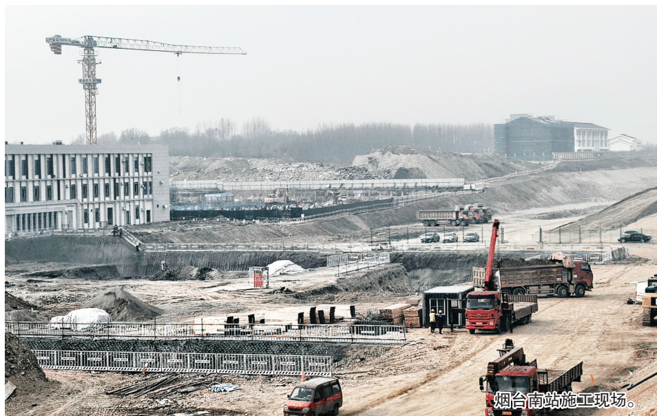
烟台南站施工现场。
