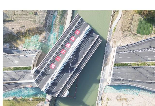
11月28日拍摄的平转式开启桥“三灶港桥”(无人机照片)。
