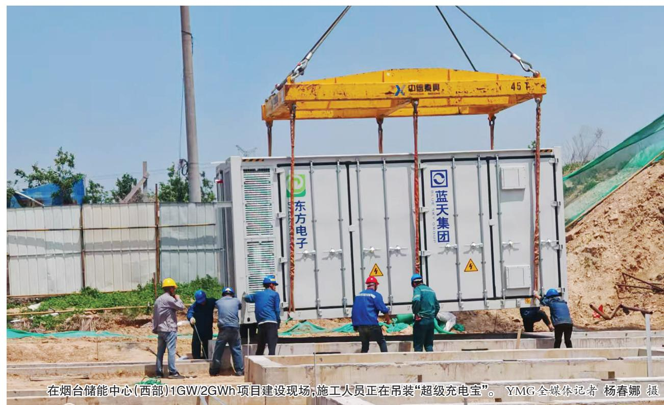
在烟台储能中心(西部)1GW/2GWh项目建设现场，施工人员正在吊装“超级充电宝”。YMG全媒体记者 杨春娜 摄
