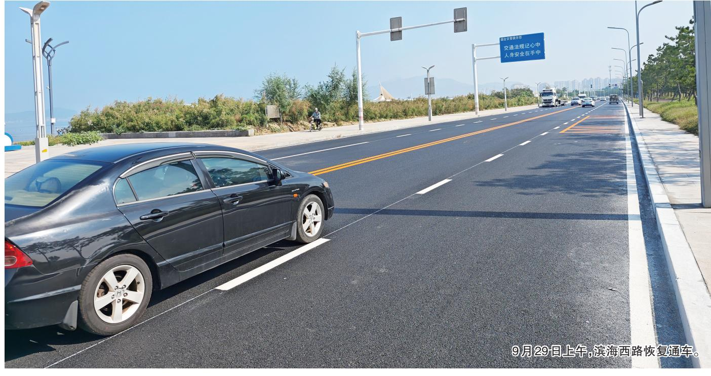
须尽快“强筋健骨”。针对滨海西路现状,项目部对部分基层薄弱区域进行基层重构施工,并对沥青面层进行了全面罩面处理,短短13天,路面焕然一新。
